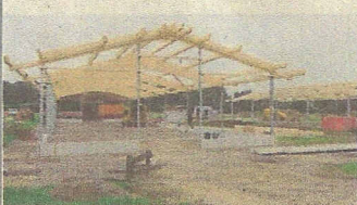
Noch steht erst das „Gerippe“ der neuen Pferdeställe.
